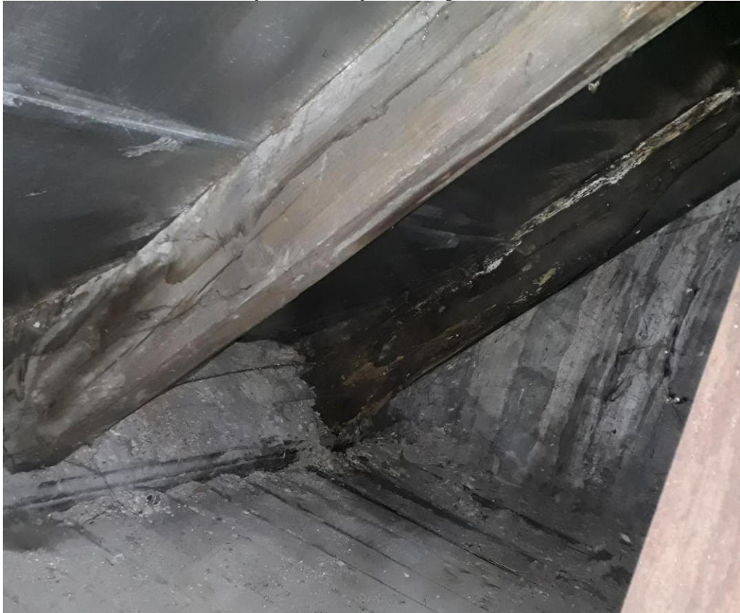
Fot3: Nieszczelne połączenie dachu i komina:
